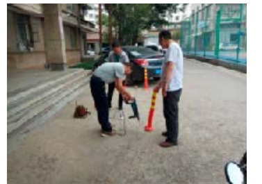
东二院学生宿舍安装消防警示柱
